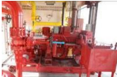
ระบบปั้มน้ำดับเพลิง (Fire Pump) จำนวน 2 ชุด
